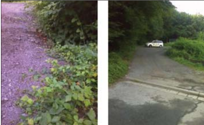
Abbruchstelle Wendeplatz Schillerstraße
